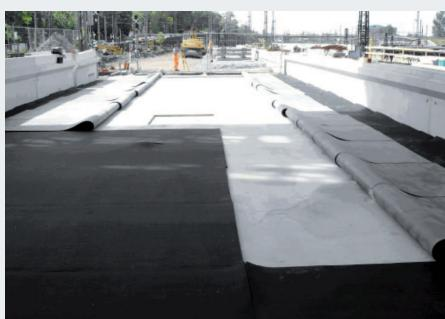
Die Wahl des zu verwendenden Klebers richtet sich nach der jeweiligen Umgebungstemperatur, die in der Regel +5 °C nicht unterschreiten sollte. Idealerweise wird dazu ein lösungsmittelfreier Zweikomponenten-Polyurethanekleber verwendet. Der Klebstoffbedarf beträgt ca. 0,3 bis 0,5 kg/m<sup>2</sup> Unterschottermatte. In Sonderfällen sind Abweichungen hiervon möglich. Um die Verklebung möglichst einfach zu gestalten, hat es sich bewährt, eine überschaubare Anzahl von USM zur Hälfte umzuschlagen.
